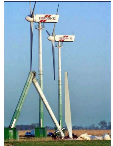
10.02.2000, Mastbruch Enercon E 32, 300 kW Baujahr: 1992 Standort: Asel im Kreis Wittmund / Niedersachsen
