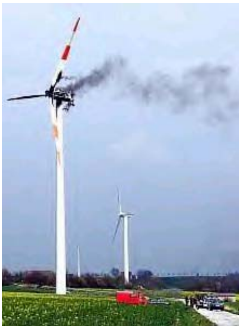
20.4.2002, Feuer VESTAS 1,5 MW, Gesamthöhe: 108 m Baujahr: 2000 Standort: Bad Wünnen- berg-Haaren bei Paderborn
