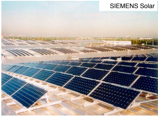
Solargenerator München, 7800 m 2 Solarzellen, 1000 kW p , Netzleistung am Tag der Sonnenfinsternis, 11. August 1999
