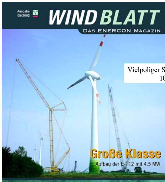
4.5 MW Enercon E-112, Windrad für den off-shore Einsatz Variable Drehzahl, getriebeles, Flügel individuell verstellbar, 112 m Rotor Durchmesser, IGBT Spannungs-Zwischenkreis Umrichter, sinusförmiger Strom, geregelter Leistungsfaktor
