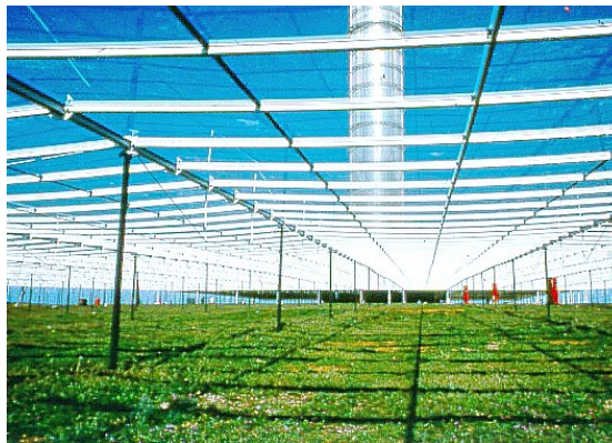
Abb. 13: Glaskollektor des Prototyps in Manzanares, Spanien.
