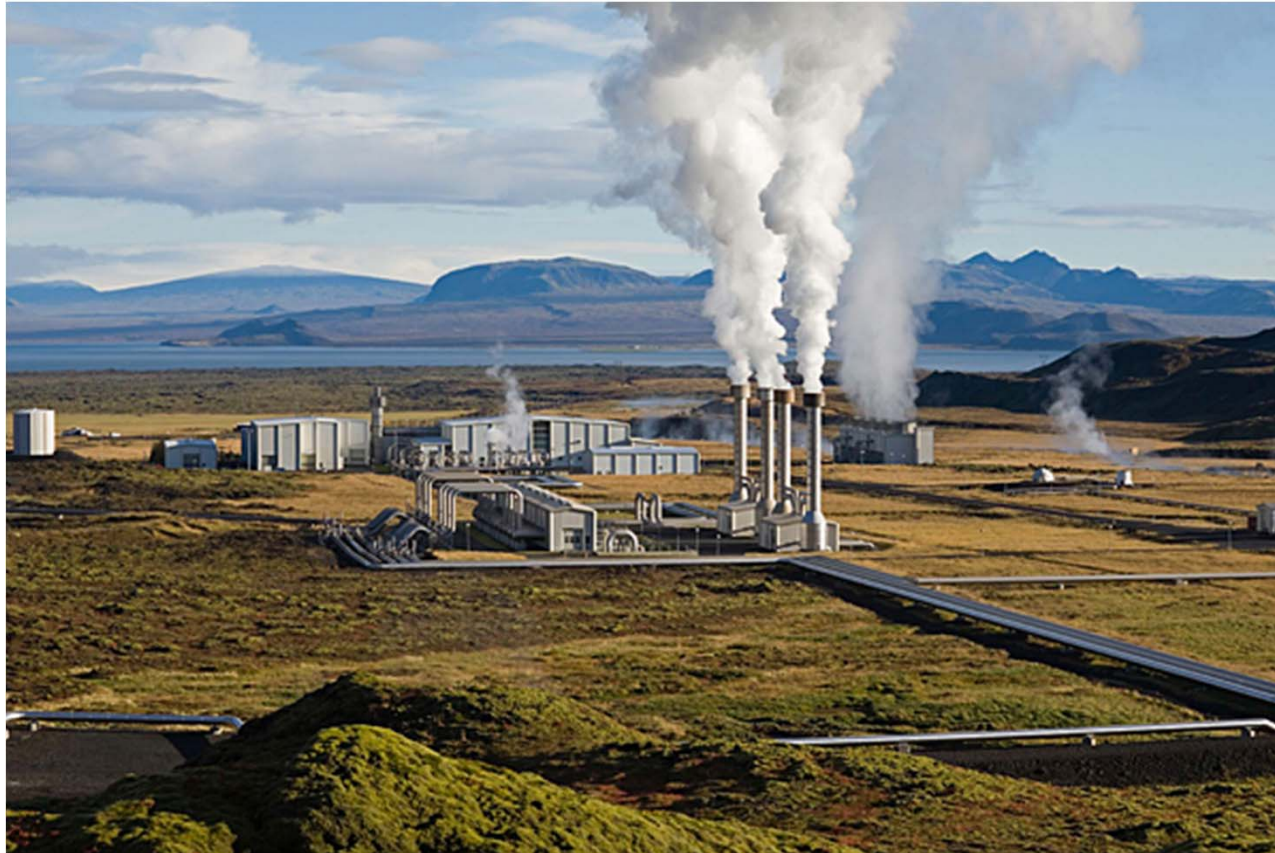
Geothermiekraftwerk Nesjavellir, Island
