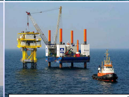
Aufbau der Trafo- und Übergabestation mit Hubschrauber-Landeplattform
