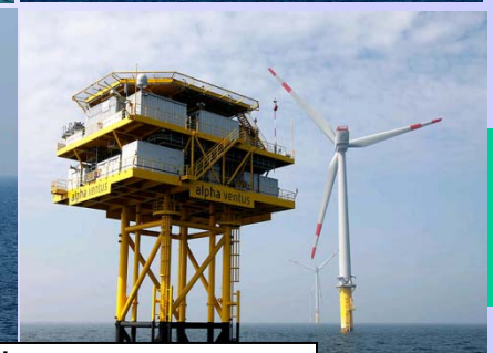
Aufbau der Trafo- und Übergabestation mit Hubschrauber-Landeplattform
