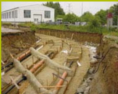
Cross-Bonding und Muffenboxen für AC-Kabel
