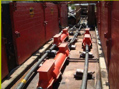
Cross-Bonding und Muffenboxen für AC-Kabel
