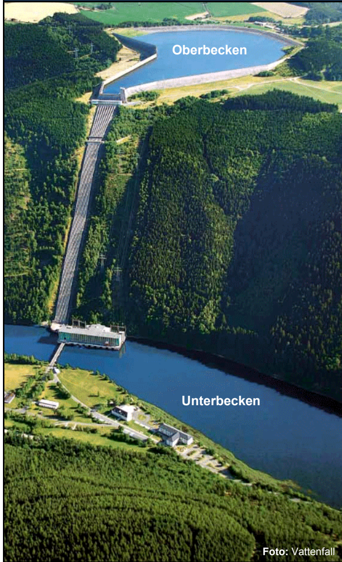
Pumpspeicherkraftwerk Hohenwarte II, Thüringen
