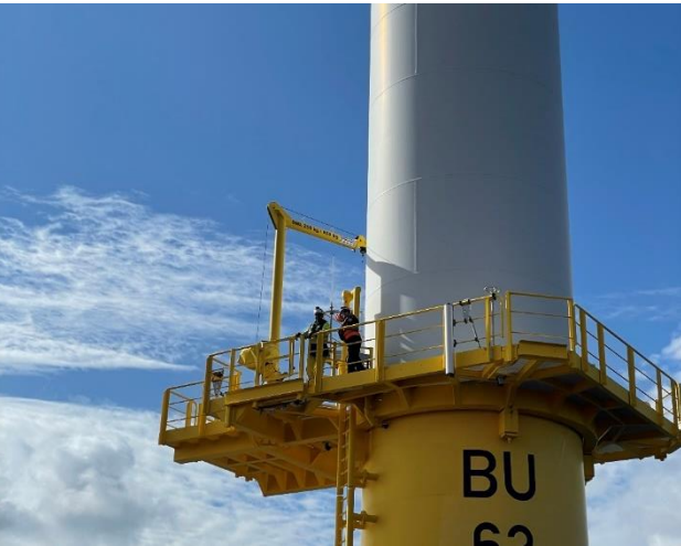
Liftinspektion an einer Offshore Windenergieanlage
