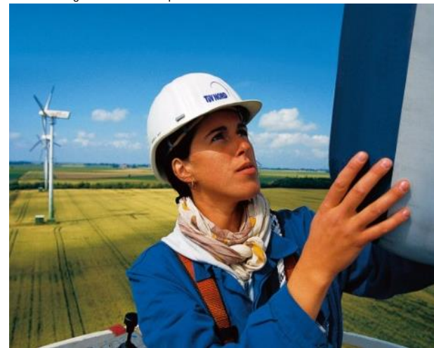
Rotorblattprüfung an einer Onshore Windenergieanlage
