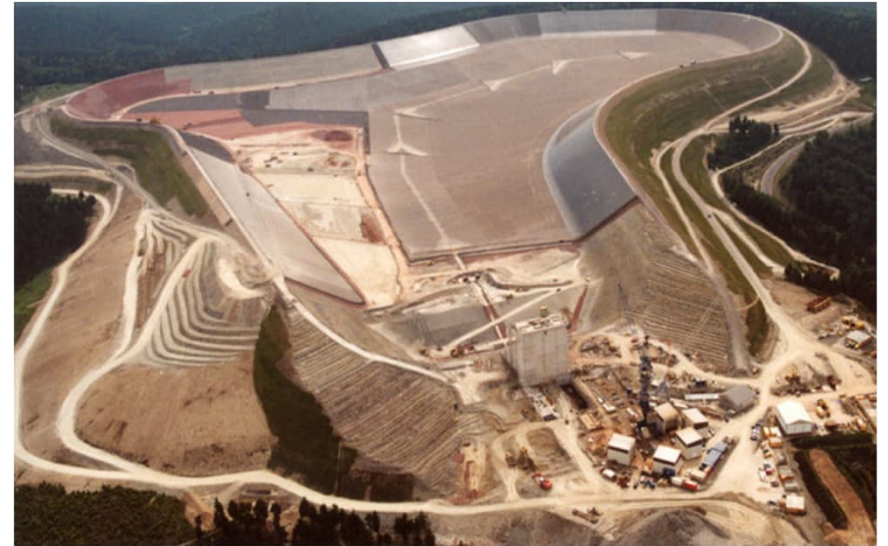
Bau Oberbecken Goldisthal
