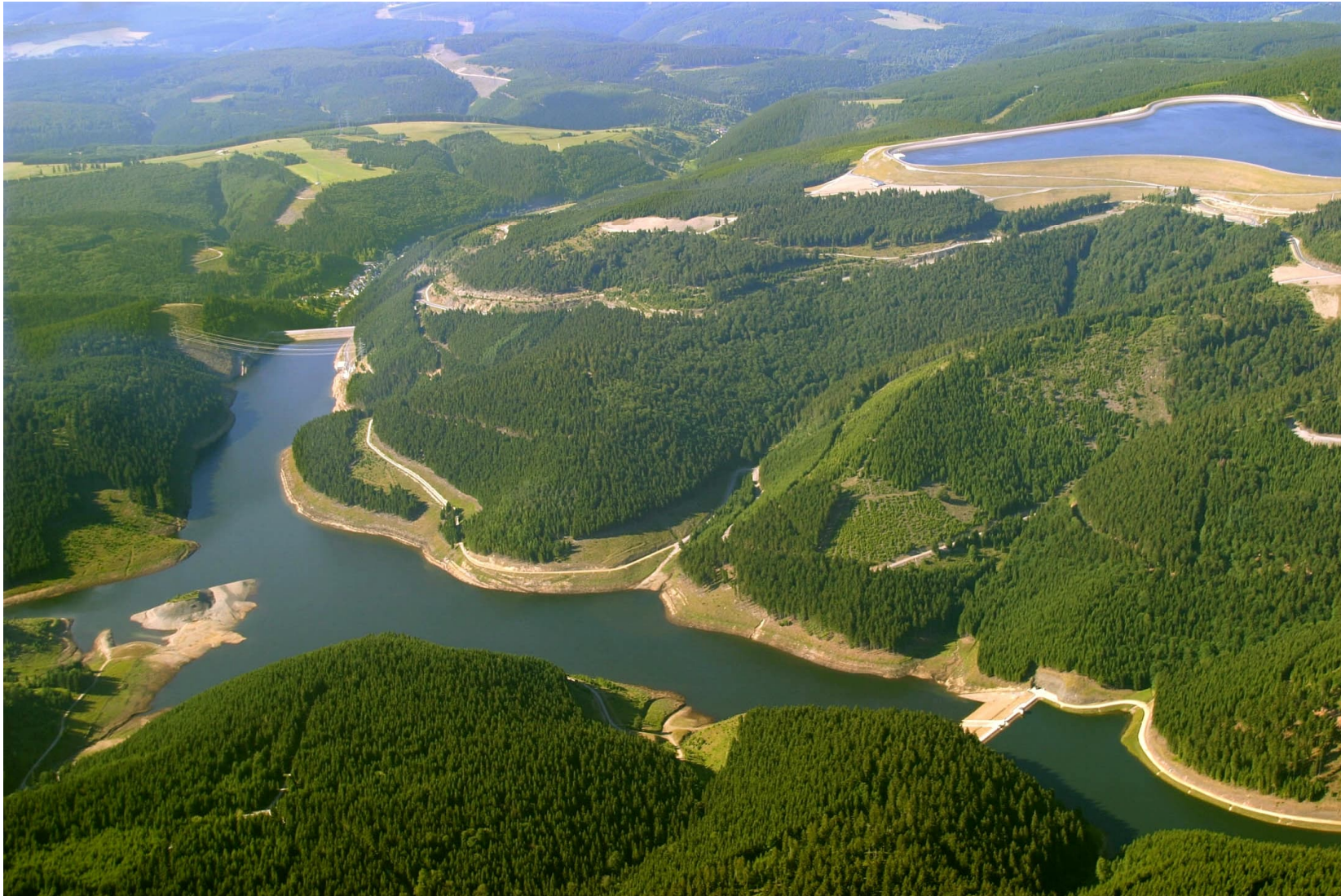
Pumpspeicherwerk Goldisthal mit Ober -und Unterbecken (installierte Leistung 1.060 MW)
