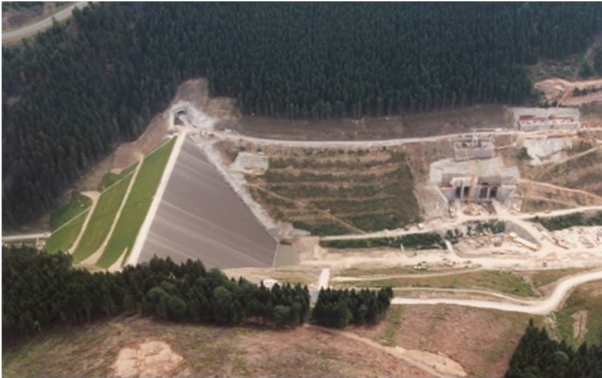
Bau Unterbecken Goldisthal
