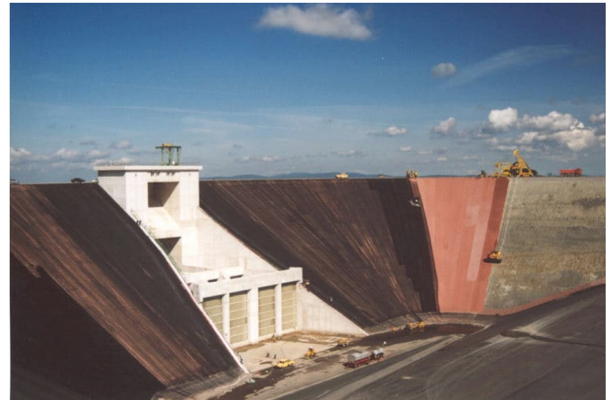
Einlaufbauwerk Oberbecken Goldisthal
