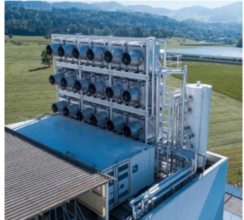
Weltweit erste kommerzielle DAC-Anlage (Climeworks, Hinwil); DAC-18, 900 t CO<sub>2</sub>/a; scinexx, 6. June 2017, <http://bit.ly/2s7uvvH>
