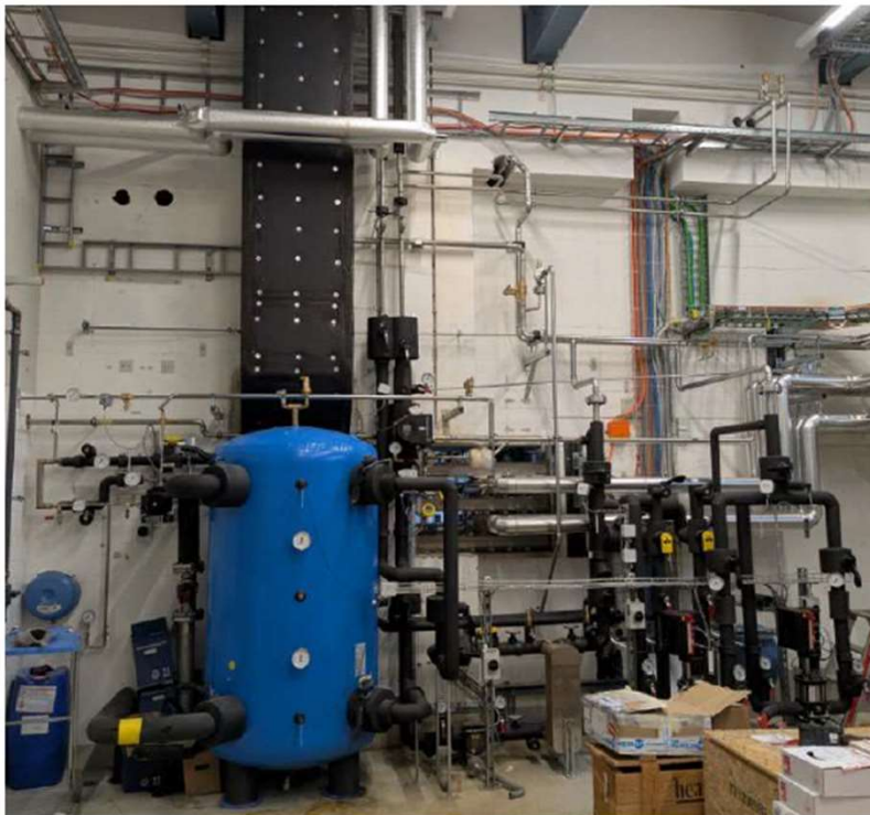
1 Neue Kühlwasser Feinverteilung für Metafuels
