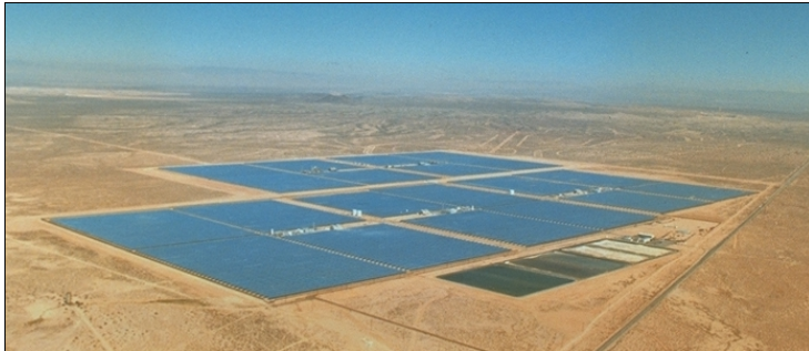
SEGS Kraftwerke/Kramer Junction: 5 x 30 MW, 25% Gaszufuehrung
