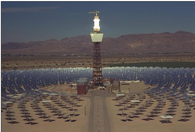
Abb. 2: 10 MW Demonstrationsanlage („Solar Two“) des amerikanischen Salzturmkonzepts in Barstow, Kalifornien (Quelle: Sandia National Laboratories)
