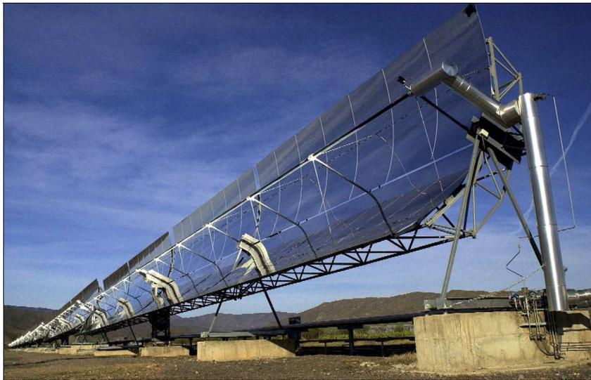
Abb. 4: 500 m Direktverdampfungs-Testkollektor auf der Plataforma Solar in Almería, Spanien (Quelle: DLR)
