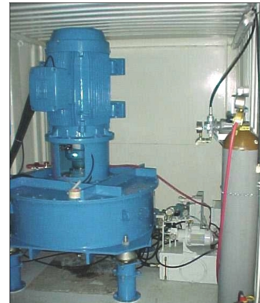
Abb. 3: Schwungrad als Energiespeicher zum Ausgleich kurzzeitiger Schwankungen.
