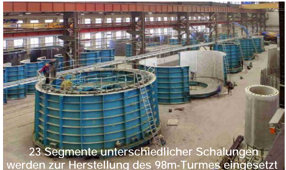
Fertigteilbetonturm in der Produktion...
