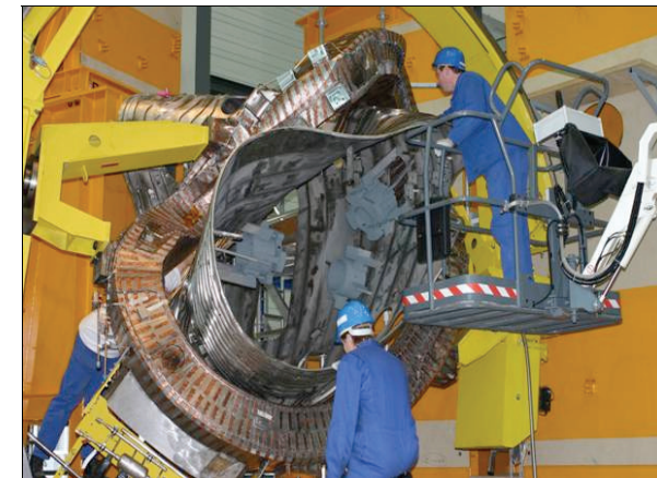
Abb.10: Die Montage einer Stellaratorspule an Wendelstein 7-X zeigt die Größe des Experiments.
