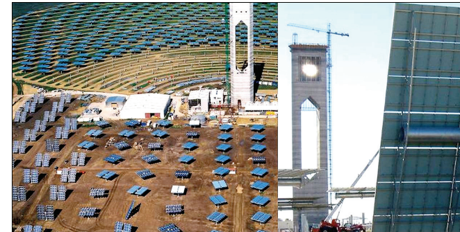
Abb. 1: „PS10“, das erste kommerzielle solarthermische Kraftwerk in Spanien befindet sich im Aufbau
