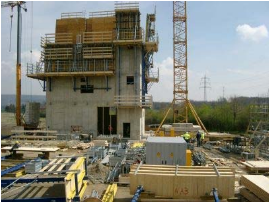
Abbildung 3: Bild aus dem Bau der Solarturmkraftwerks Jülich, Quelle: Stadtwerke Jülich
