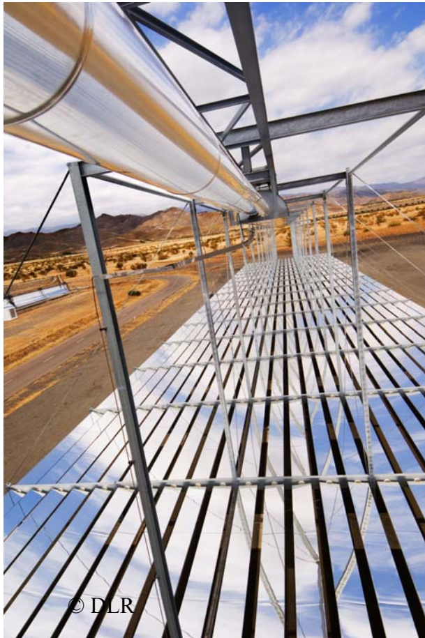
Abbildung 4: Beispiel eines Fresnel Kollektors, Quelle: DLR
