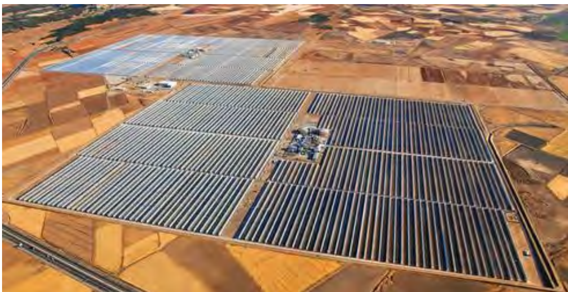
Abb. 4: 50 MW e Andasol Kraftwerke in der Nähe von Guadix (Spanien)
