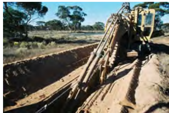
Abb. 8: Links: Landkabelverbindung Murraylink in Australien. Rechts: Kabelverlegung.
