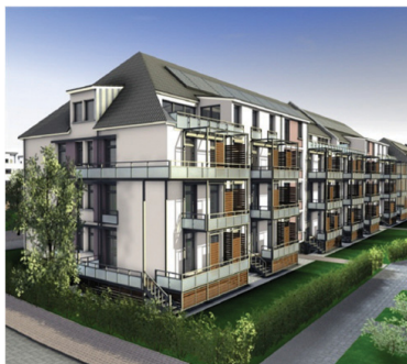
Abbildung 10: Ansicht des sanierten Gebäudes (Quelle: www.citylivingxxl.de )
