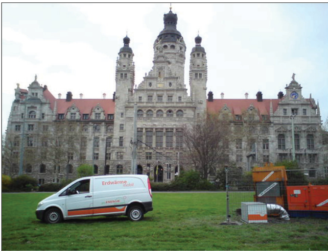
Abbildung 6: Durchführung geothermischer Testarbeiten auf einem potenziellen Erdwärmesondenfeld (Trinitatis-Kirche in Leipzig)
