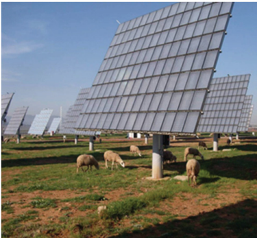
Abbildung 13: Links: Photo eines Konzentratorensystems der Firma Soitec Solar in Spanien. Dieses System nutzt Fresnellinsen, welche das Sonnenlicht auf ca. 3 \text{ mm}^2 große Solarzellen fokussieren, die auf einem Wärmespreizer montiert sind. Das Schema und die Dimensionen sowie das Vorgehen bei der thermischen Simulation sind im rechten Bild gezeigt.
