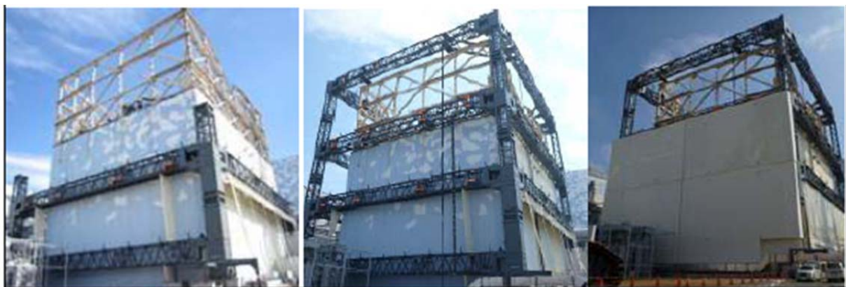
Abbildung 4: Errichtung eines Stahlgerüsts mit Umhausung für Reaktorblock 1 [3].
