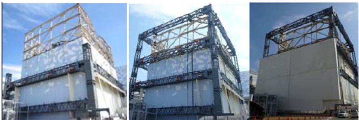
Abbildung 4: Errichtung eines Stahlgerüsts mit Umhausung für Reaktorblock 1 [3].
