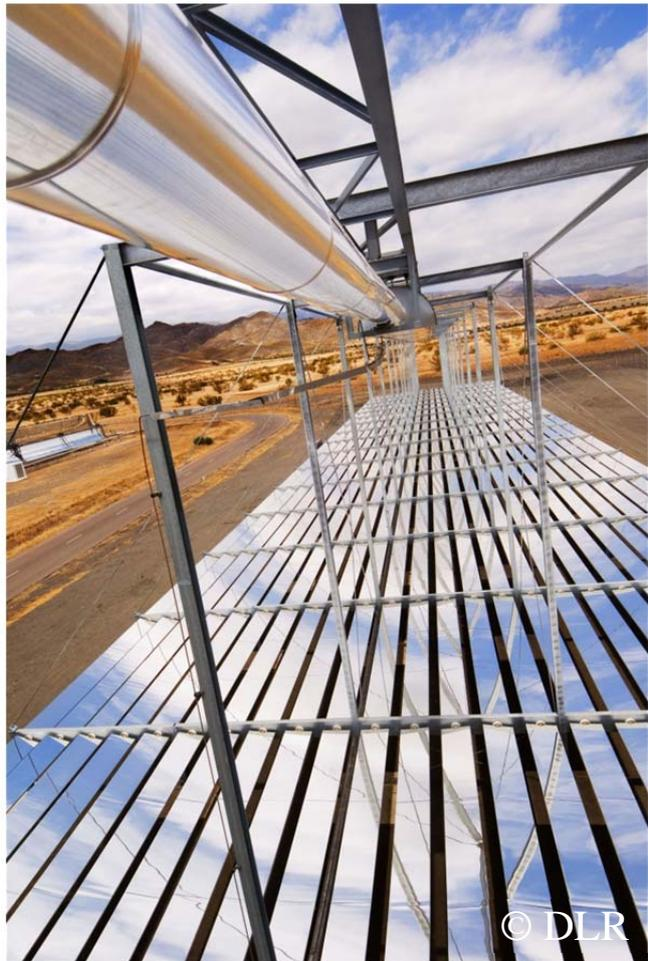
Abbildung 4: Beispiel eines Fresnel Kollektors, Quelle: DLR
