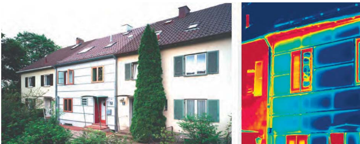
Abb. 5: Mit Vakuumisolationspaneelen energetisch saniertes Reihenmittelhaus (Baujahr 1956). Der U-Wert der hier gezeigten Nordfassade konnte von ursprünglichen 1 \text{ W}/(\text{m}^2\text{K}) auf 0.15 \text{ W}/(\text{m}^2\text{K}) reduziert werden. Die entsprechende Thermografieaufnahme in der rechten Bildhälfte zeigt die mit verminderten Wärmeverlusten einhergehende deutlich erniedrigte Außenwandtemperaturen (blaue Farben).
