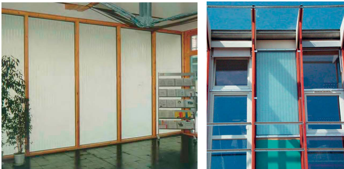
Abb. 8: Innenansicht (links) und Außenansicht (rechts) zweier Anwendungsbeispiele für transparente Wärmedämmungen aus Aerogelgranulat in Doppelstegplatten. Mit einem Wärmedurchgangskoeffizienten U = 0.4 \text{ W}/(\text{m}^2\text{K}) und einem Gesamtenergiedurchlassgrad g = 0.4 erreicht man auch an der Nordseite eines Gebäudes über die Heizperiode eine ausgeglichene Energiebilanz.
