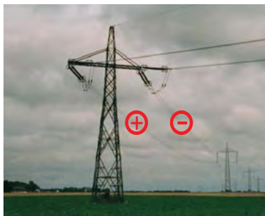
Abb. 10: Zusätzlich zum Wechselstromverteilernetz wird in Zukunft ein Overlay-Gleichstromnetz gebraucht, welches die zeitlichen Schwankungen in Erzeugung und Verbrauch durch großräumige Vernetzung reduziert. Dieses Netzwerk wird in Hochspannungsgleichstromtechnik realisiert, um Transportverluste zu minimieren. Es kann oberirdisch oder als Erdkabel realisiert werden. Eine weitere Möglichkeit zum Energietransport auf große Entfernungen besteht in Pipelines für den Transport erneuerbarer Gase [13].
