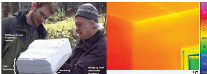
Abbildung 13: Probenahme nach 25 Jahren aus der Außenwand am Pilotprojekt und Innenthermographie der dauerhaft wärmebrückenfreien und luftdichten Konstruktion [Feist 2016a]
