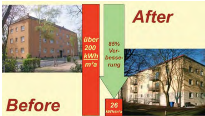
Abbildung 5: Energieeffizienzverbesserung um einen Faktor mehr als 6 für ein Bestandsgebäude in Nürnberg/Architekt Schulze-Darup [AkkP 24]. Hier liegen Messergebnisse über mehrere Jahre vor, die erzielten Einsparungen entsprechen den Erwartungen. (Für eine Analyse vgl. auch Abbildung 6)
