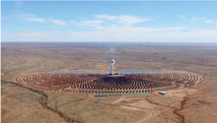
Abb. 12: Solarturmkraftwerke fokussieren Sonnenlicht zweidimensional und erzeugen Wärmeenergie bei hohen Temperaturen. Die Energie kann in Wärmespeichern zwischengespeichert werden und bei Bedarf mit hohem Wirkungsgrad in Strom umgewandelt werden. Mit Hilfe katalytischer Prozesse können ohne Umweg über die Stromerzeugung direkt erneuerbare Energieträger (z.B. Wasserstoff) erzeugt werden (Foto: Turmkraftwerk Khi Solar One, Südafrika) [17].
