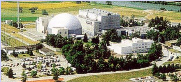
**Kernkraftwerk Leibstadt/Schweiz, Inbetriebnahme Ende 1984, Siedewasserreaktor von General Electric mit 1.275 MW elektrischer Bruttoleistung.**
