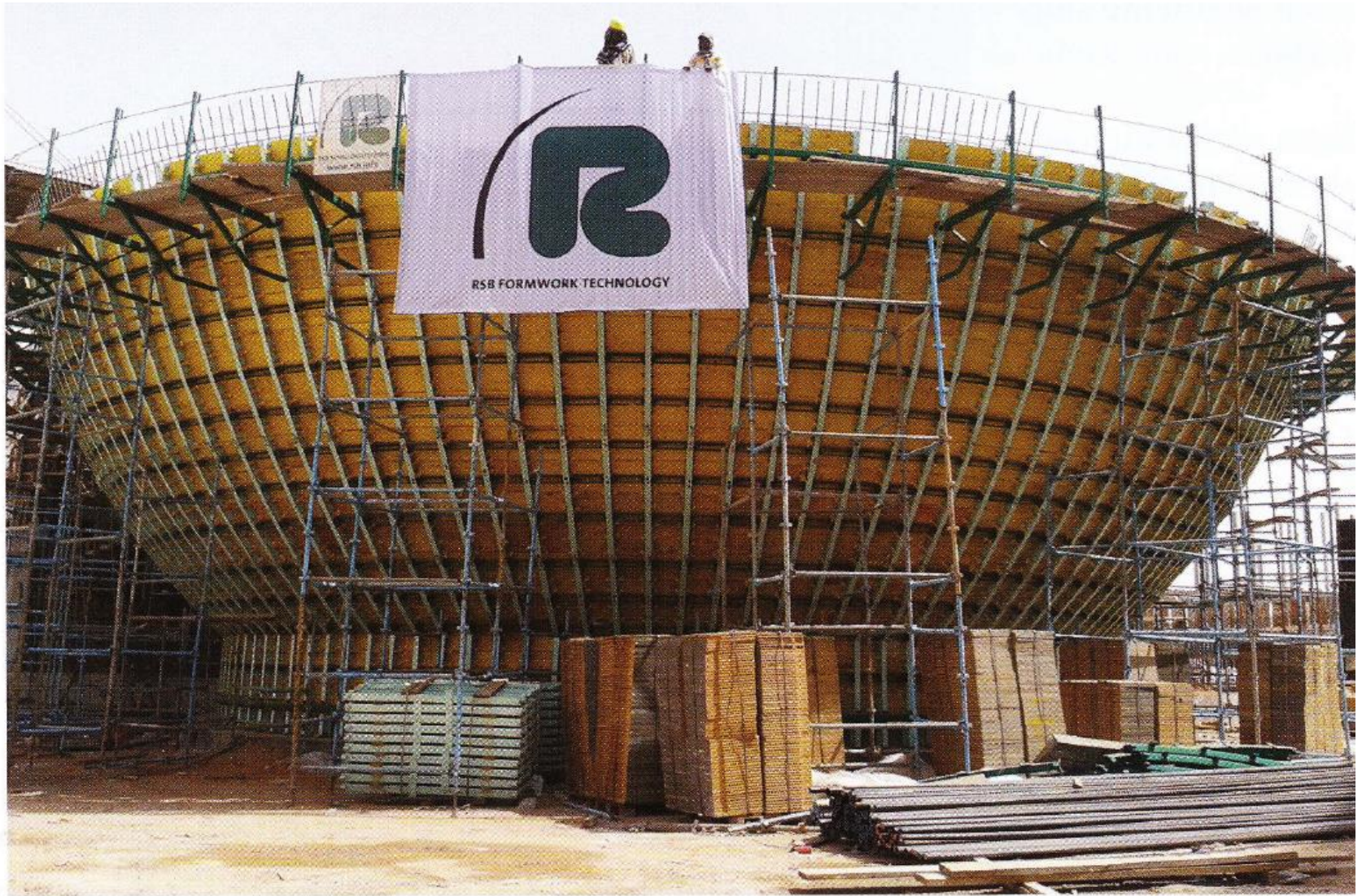
Bild 13. Schalungsarbeiten zur Herstellung einer dünnwandigen Betonhohlkugel
